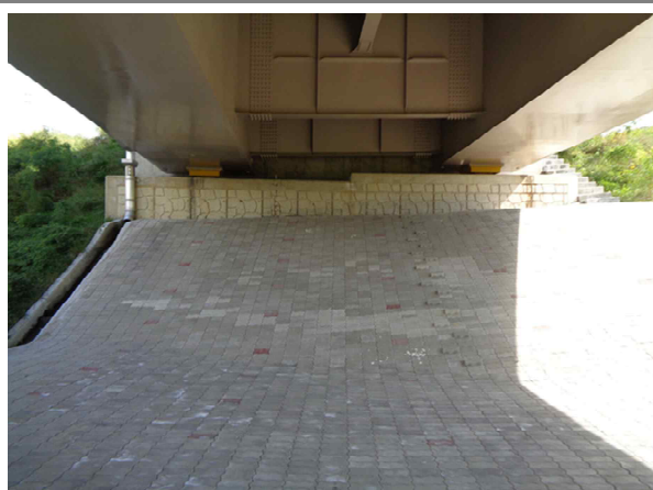
교량 하부 전경
