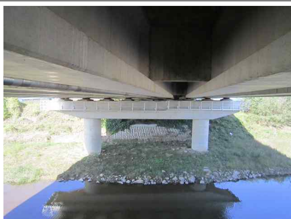
교량 하부 전경
