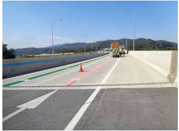
교량 상부 전경
