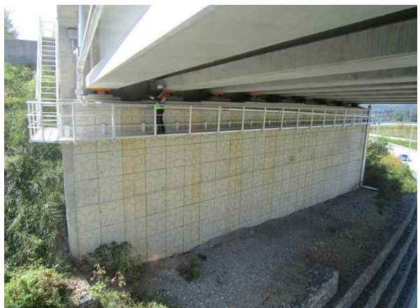
교량 하부 전경
