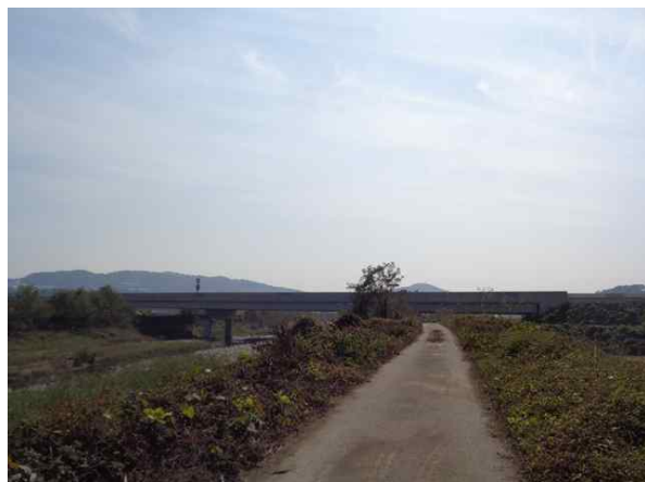
교량 측면 전경
