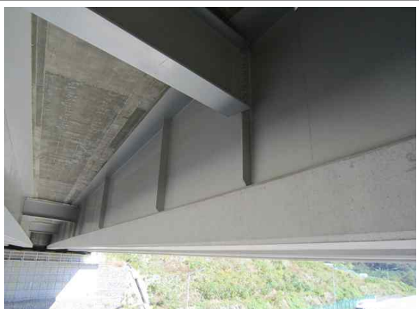
교량 거더 전경
