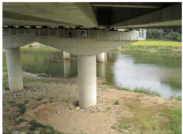
교량 하부 전경
