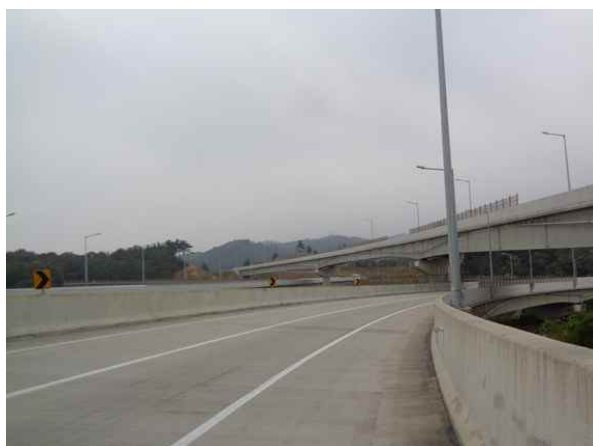
교량 상부 전경
