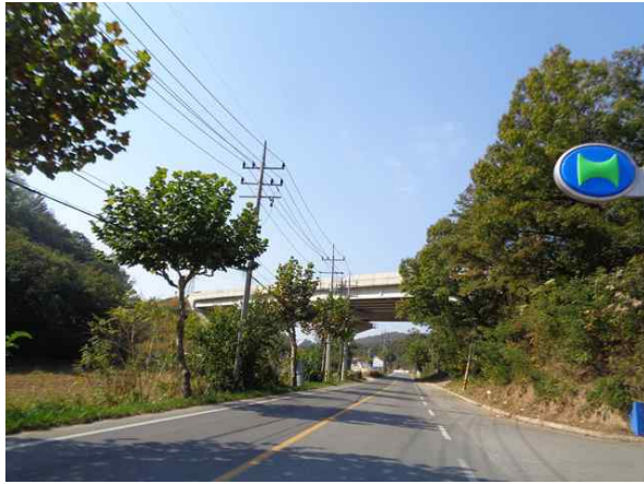
교량 측면 전경
