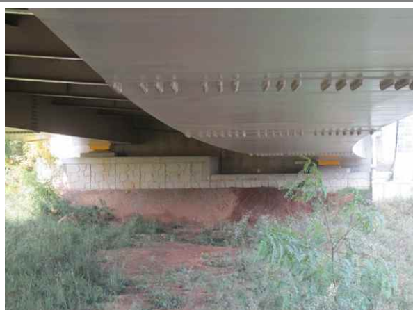
교량 하부 전경
