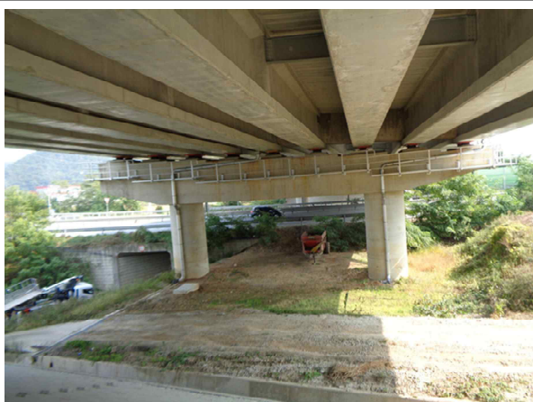
교량 하부 전경
