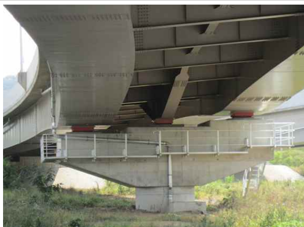
교량 거더 전경
