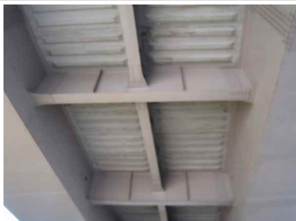
교량 바닥판 전경
