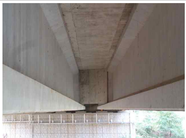
교량 거더 전경
