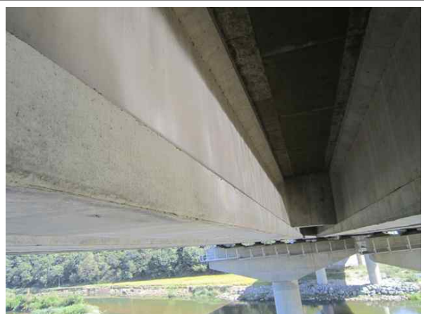
교량 거더 전경
