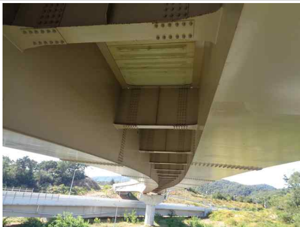
교량 바닥판 전경
