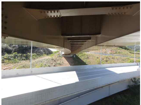
교량 거더 전경
