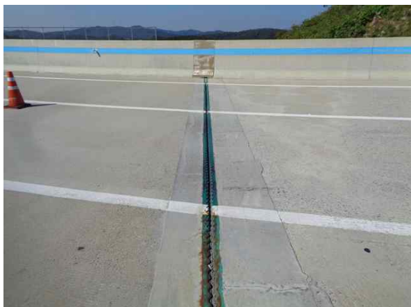
교량 상부 전경
