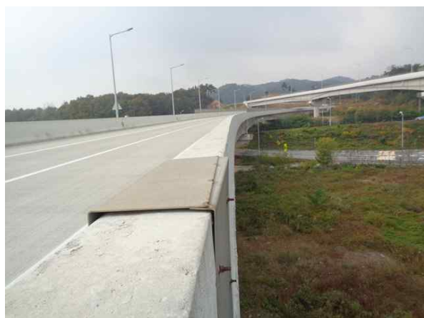
교량 측면 전경
