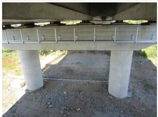
교량 하부 전경
