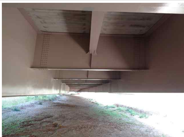
교량 거더 전경
