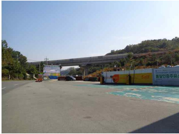
교량 측면 전경
