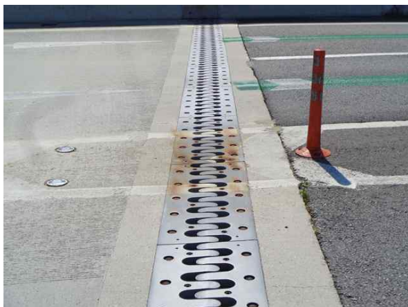
교량 상부 전경
