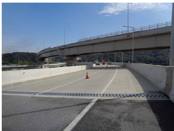
교량 상부 전경
