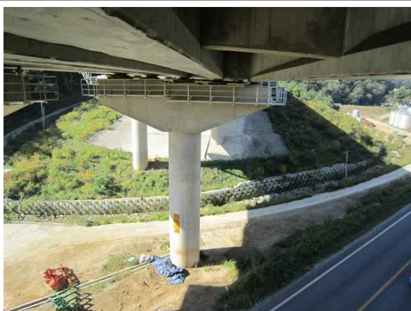
교량 하부 전경
