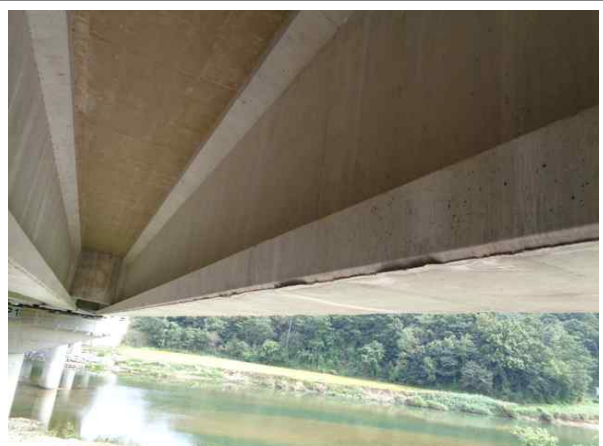
교량 거더 전경
