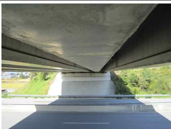
교량 하부 전경
