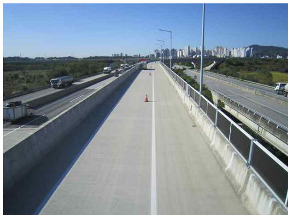
교량 상부 전경
