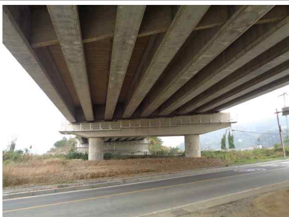
교량 하부 전경
