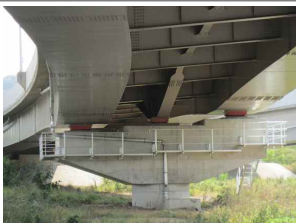
교량 하부 전경
