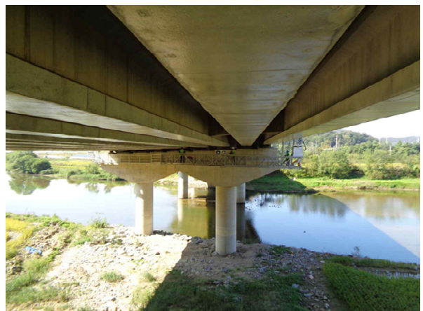
교량 하부 전경
