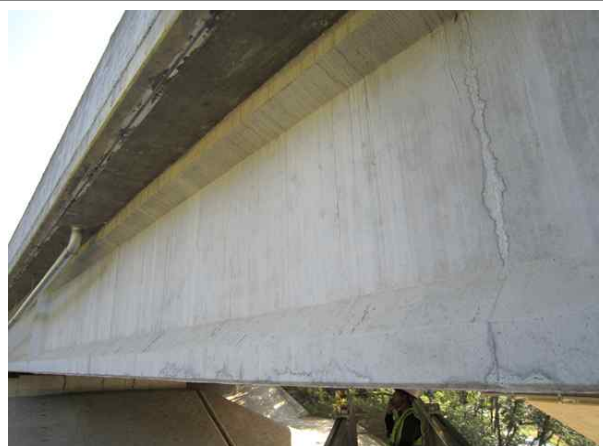
교량 거더 전경
