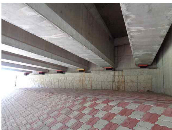
교량 하부 전경
