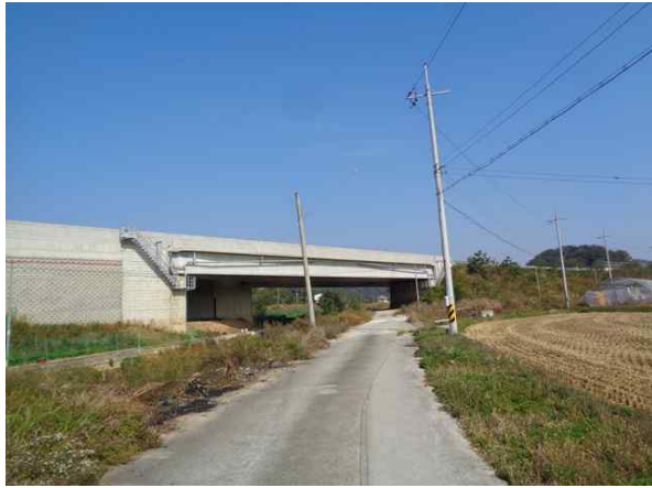
교량 측면 전경
