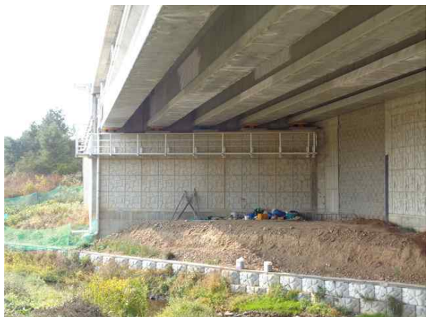
교량 하부 전경
