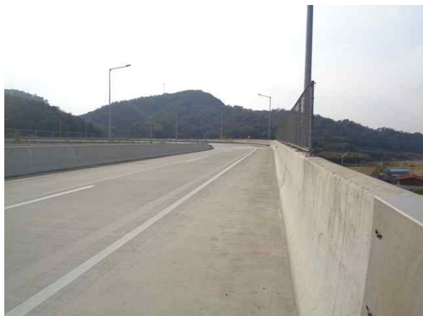
교량 상부 전경
