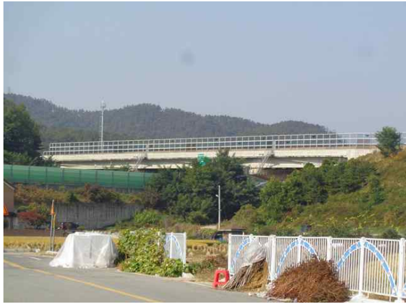
교량 측면 전경
