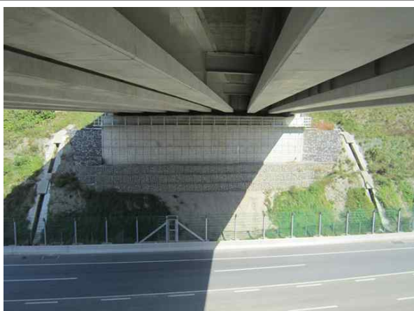
교량 하부 전경
