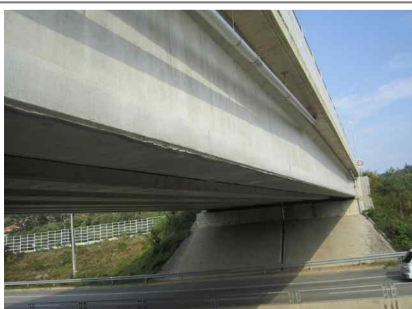
교량 거더 전경
