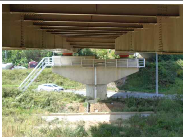
교량 하부 전경
