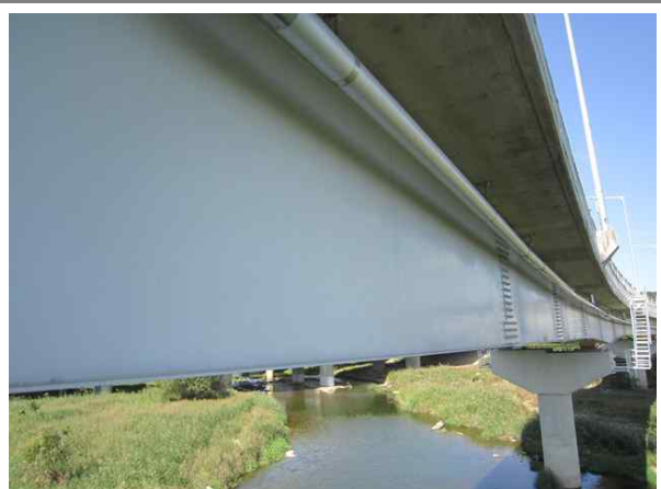
교량 거더 전경
