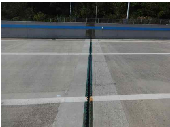
교량 상부 전경
