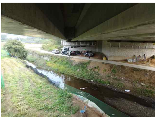
교량 하부 전경
