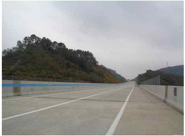
교량 상부 전경
