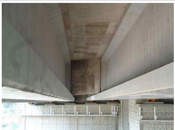
교량 거더 전경
