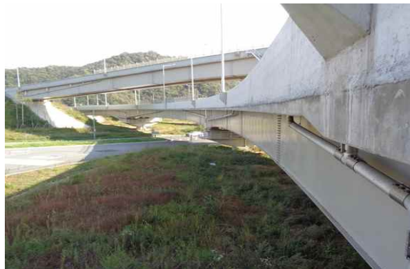
교량 측면 전경
