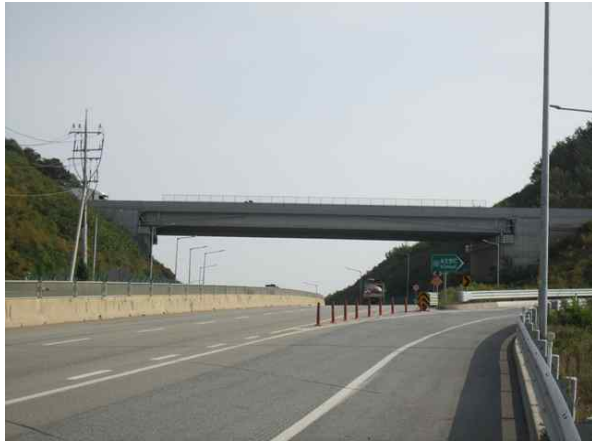
교량 측면 전경
