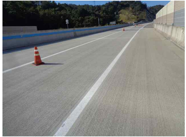
교량 상부 전경
