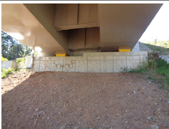
교량 하부 전경
