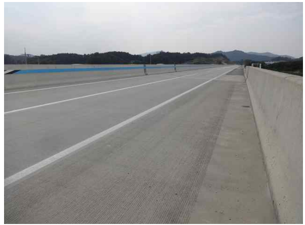
교량 상부 전경
