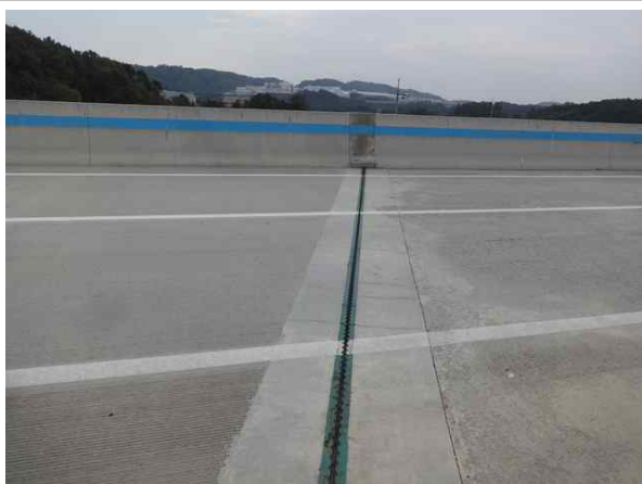
교량 상부 전경
