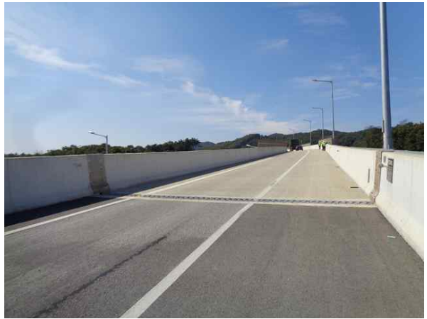
교량 상부 전경
