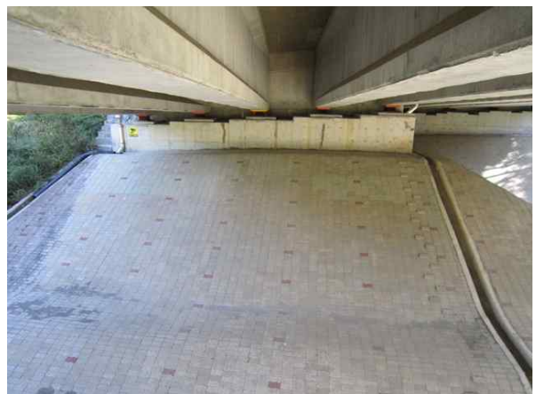
교량 하부 전경
