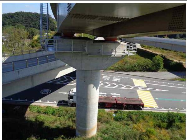
교량 하부 전경
