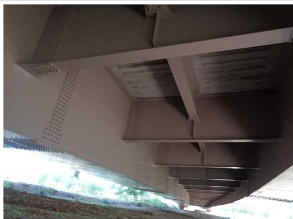
교량 바닥판 전경
