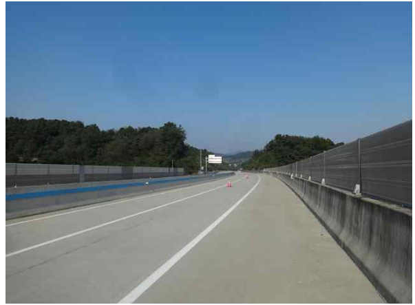
교량 상부 전경
