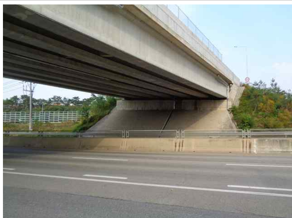
교량 하부 전경
