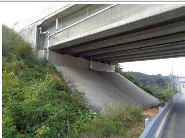
교량 하부 전경
