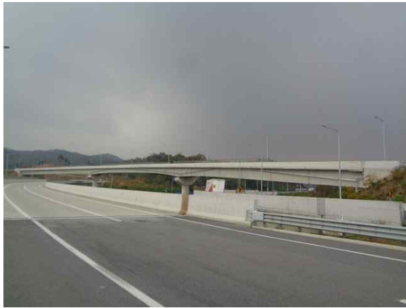
교량 측면 전경
