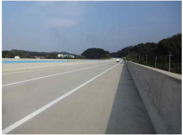
교량 상부 전경
