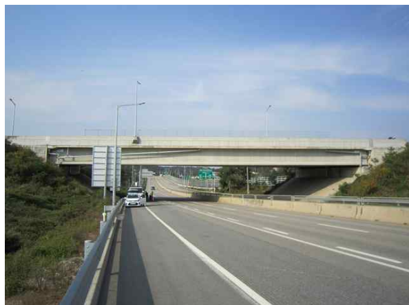
교량 측면 전경
